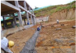
Acondicionamiento de terreno para evacuación de aguas superficialescostado orientalY COSTADO SUR
