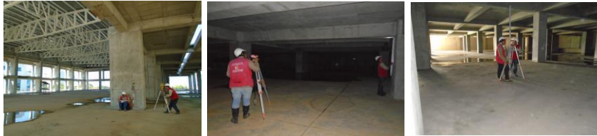
Comisión de topografía para nivelación de placas y control de deflexiones
